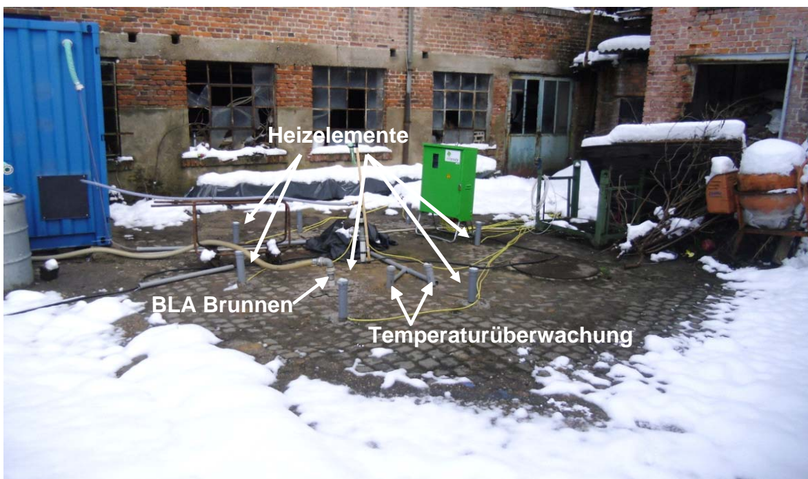
Abbildung 3.3: Standortspezifische THERIS-Pilotierung. Deutlich ist die laterale thermische Reichweite an der Oberfläche durch die Schmelze der 20 cm mächtigen Schneedecke zu erkennen (Projekt der HIM GmbH, Bereich Altlastensanierung 5 )
