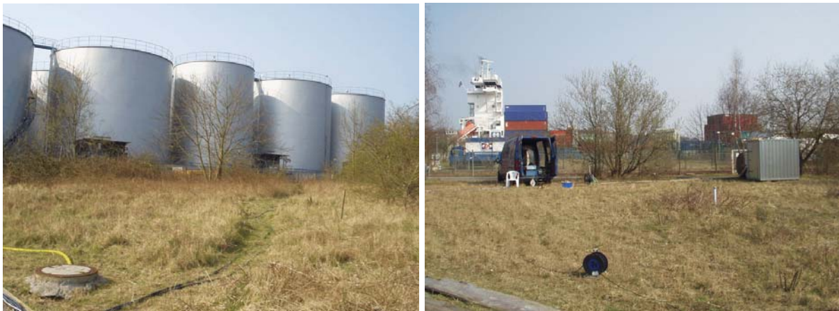
Abb. 39: Standort Kiel-Wik (links: Blick nach Süden mit Treibstofflager, rechts: Blick nach Norden mit Nord-Ostsee Kanal)
