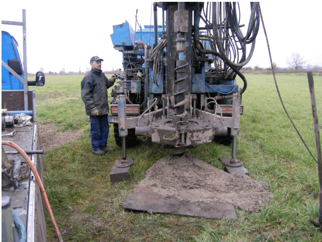
Abb. 43: Bohrarbeiten am Standort Hockenheim
