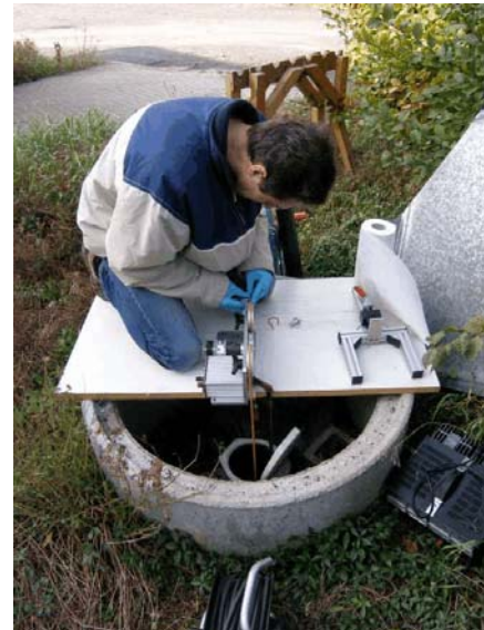
Abb. 53: Thermoflow-System am Standort Bitterfeld
