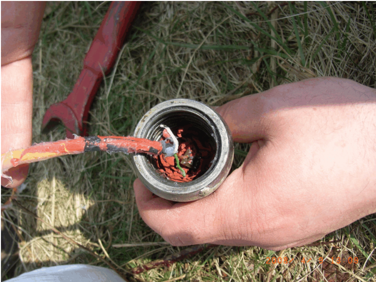
Abb. 40: Abgerissene Kabelzuführung durch beschädigte Vergussmasse
