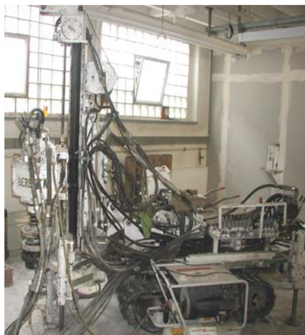
Installation der Brunnen und Temperaturmesslanzen
