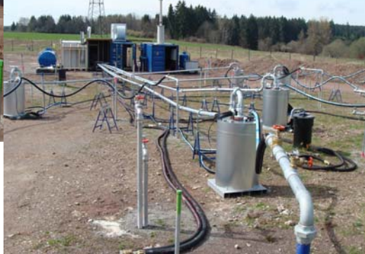
April 2012 Aufbau nahezu abgeschlossen
