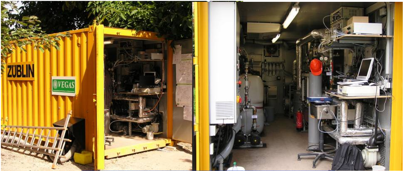
Grundwasserförderung, Bodenluftabsaugung und On-line-Datenerfassung
