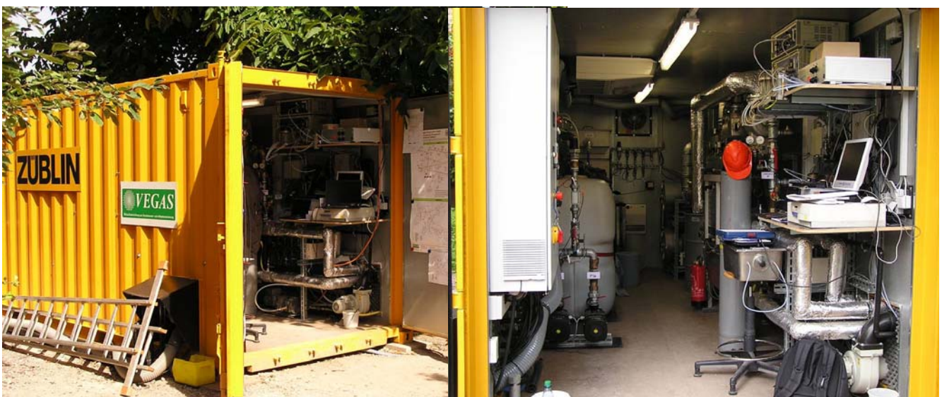
Grundwasserförderung, Bodenluftabsaugung und On-line-Datenerfassung
