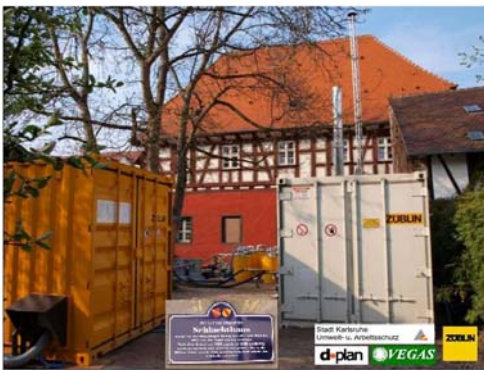
Abbildung 1: Sanierungsanlage vor dem ehemaligen Schlachthaus
