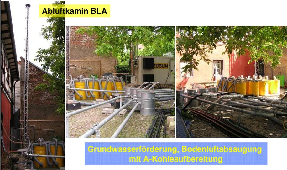
Grundwasserförderung, Bodenluftabsaugung mit A-Kohleaufbereitung
