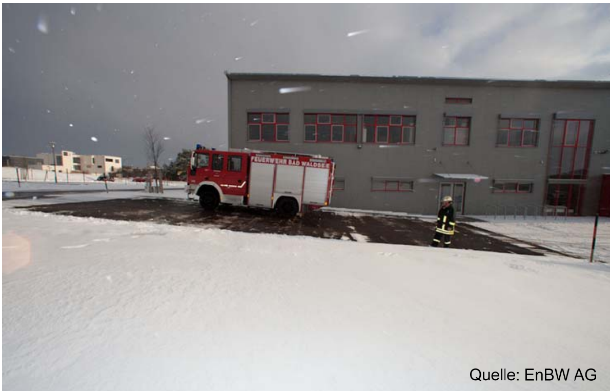
Abb. 5: Wärmebild (oben) mit Foto (unten, Quelle EnBW)) als Beleg einer funktionierenden Schnee- und Eisfreihaltung in Bad Waldsee.
