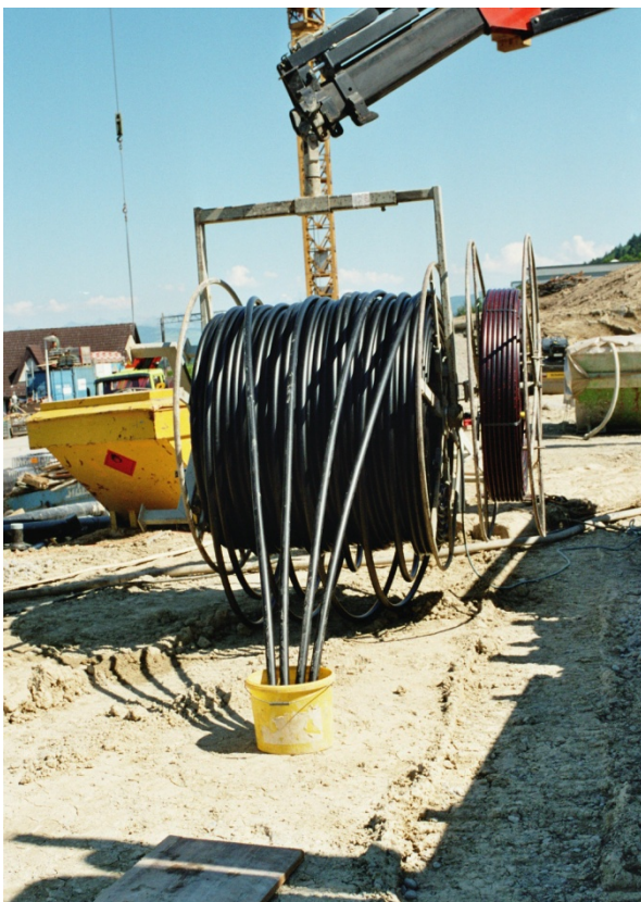
Abb. 1: Dichtheitsprüfung vor Einbau
