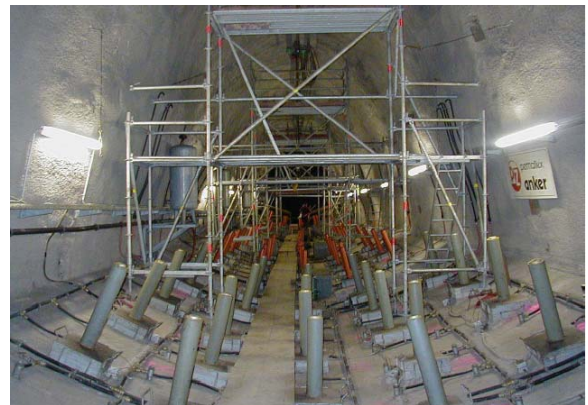
Probestollen U1 des Freudensteintunnels (Foto: E. Fecker)
