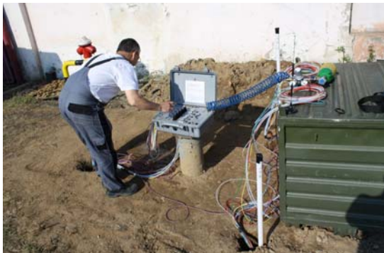
Spolchemie pilot site I, micropumps check (VEGAS/USTUTT)
