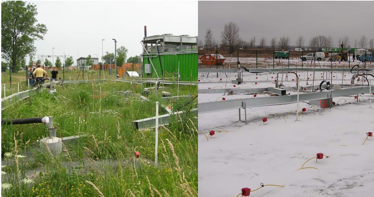
Abb. 5: Sanierungsfeld in Zeit mit Injektions- und Extraktionsbrunnen und den Einrichtungen fürs Temperaturmonitoring (rote Kästchen)
