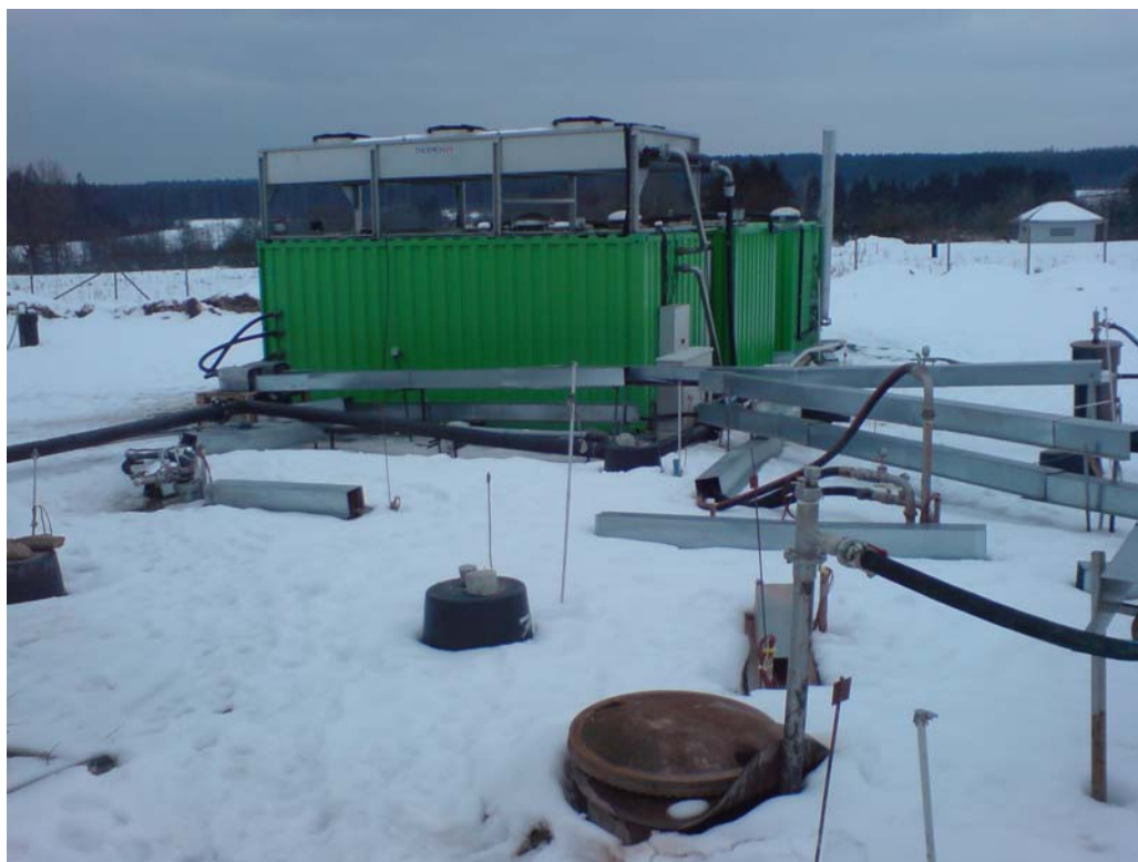
Abb. 1: Sanierungsanlage MOSAM und Ausstattung Pilotfeld (Photo VEGAS 2009)
