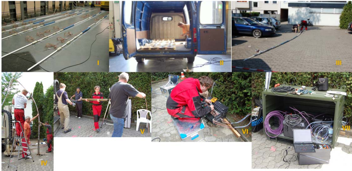
Abbildung 11: Arbeitsschritte bei der Installation der Messlanzen im Feld
