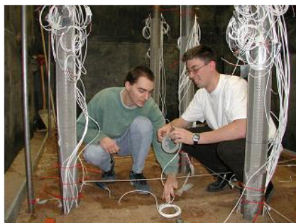
Einbau der Temperaturfühler
