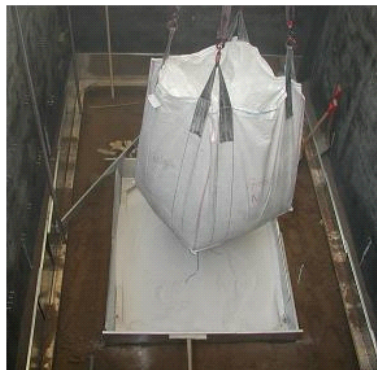
Einbau der Feinsandlinse
