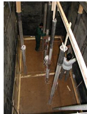
Einbau der Vertikalbrunnen
