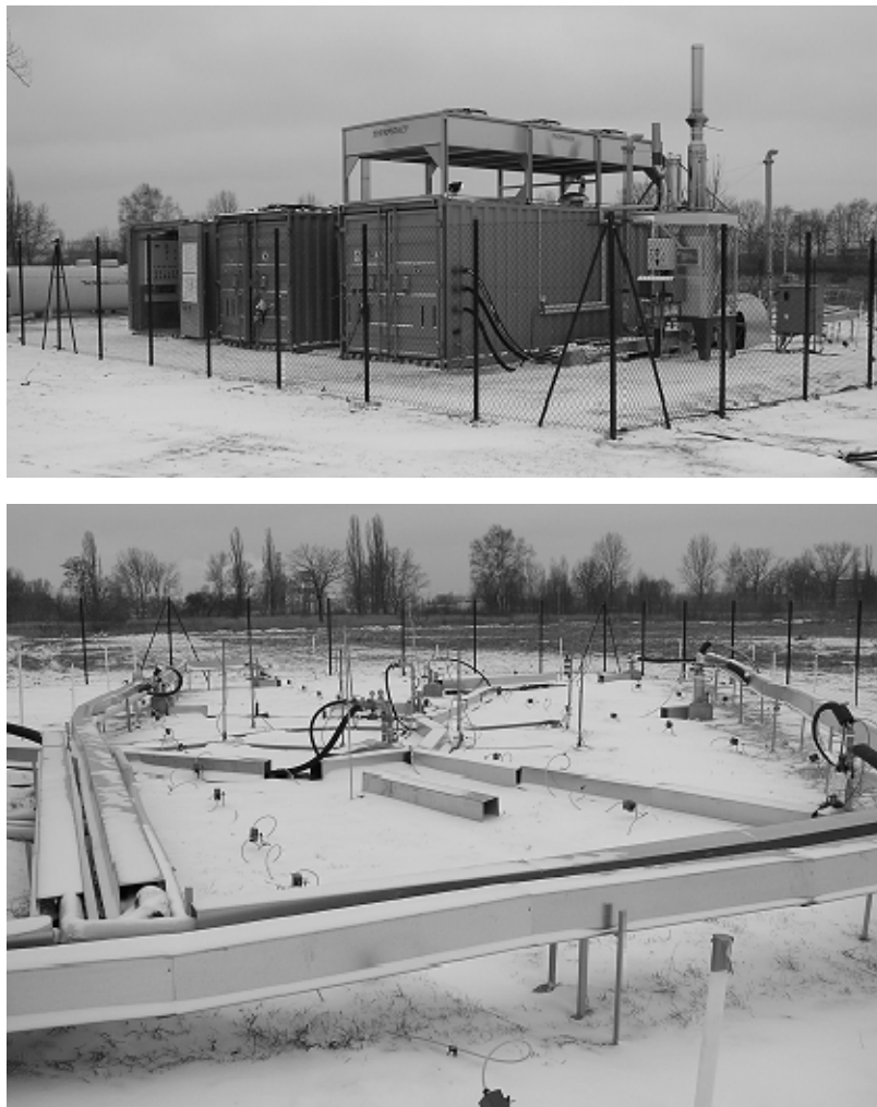
Abb. 4: Sanierungsanlage MOSAM (oben) und Ausstattung Sanierungsfeld
