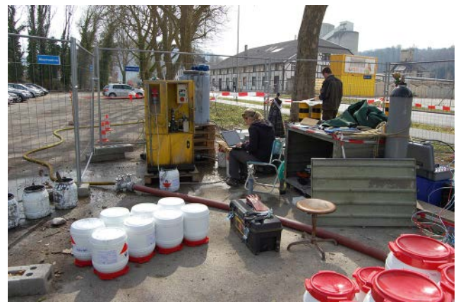
Abbildung 9: Injektion von FerMEG12 (nullwertiges nanoskaliges Eisen) in den Solvay-Standort © VEGAS, Universität Stuttgart, Deutschland
