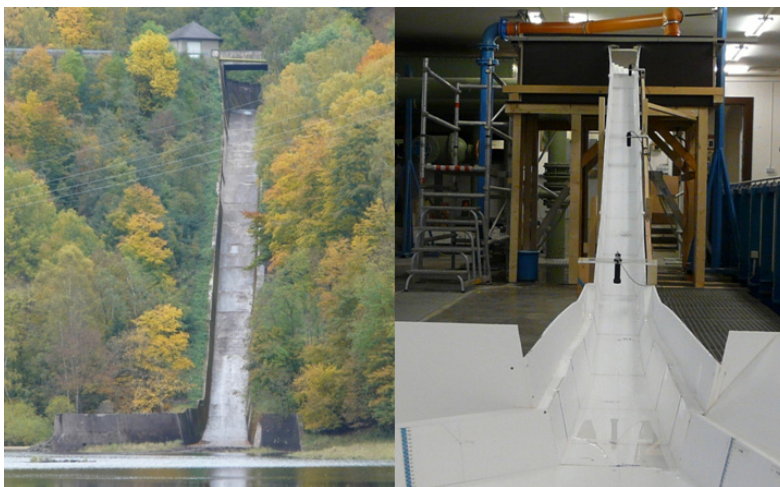
Abb. 8.1: HWE - Schussrinne - Naturbauwerk und physikalisches Modell M 1:25
