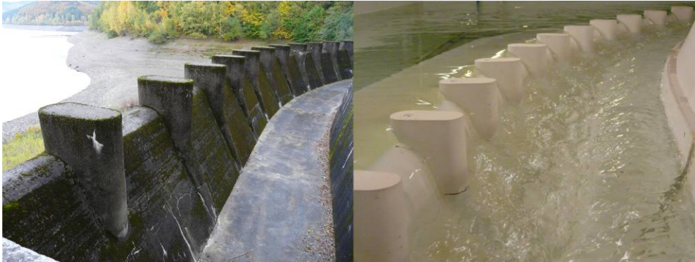
Abb. 8.3: HWE – Sammelrinne - Naturbauwerk und physikalisches Modell M 1:25
