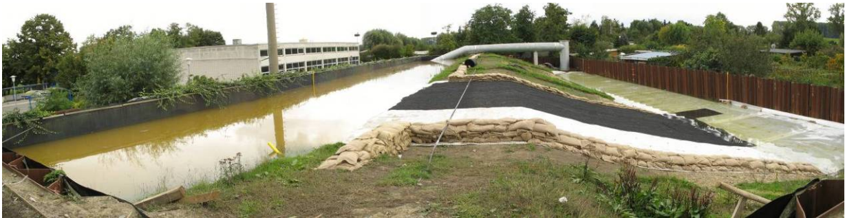
Abb. 25.3: Versuchsaufbau vor einer Überströmung (ohne Vegetationsschicht)
