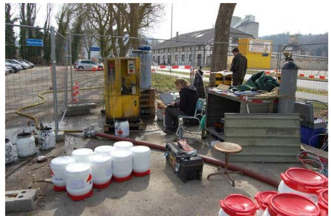
Abbildung 9: Injektion von FerMEG12 (nullwertiges nanoskaliges Eisen) in den Solvay-Standort
