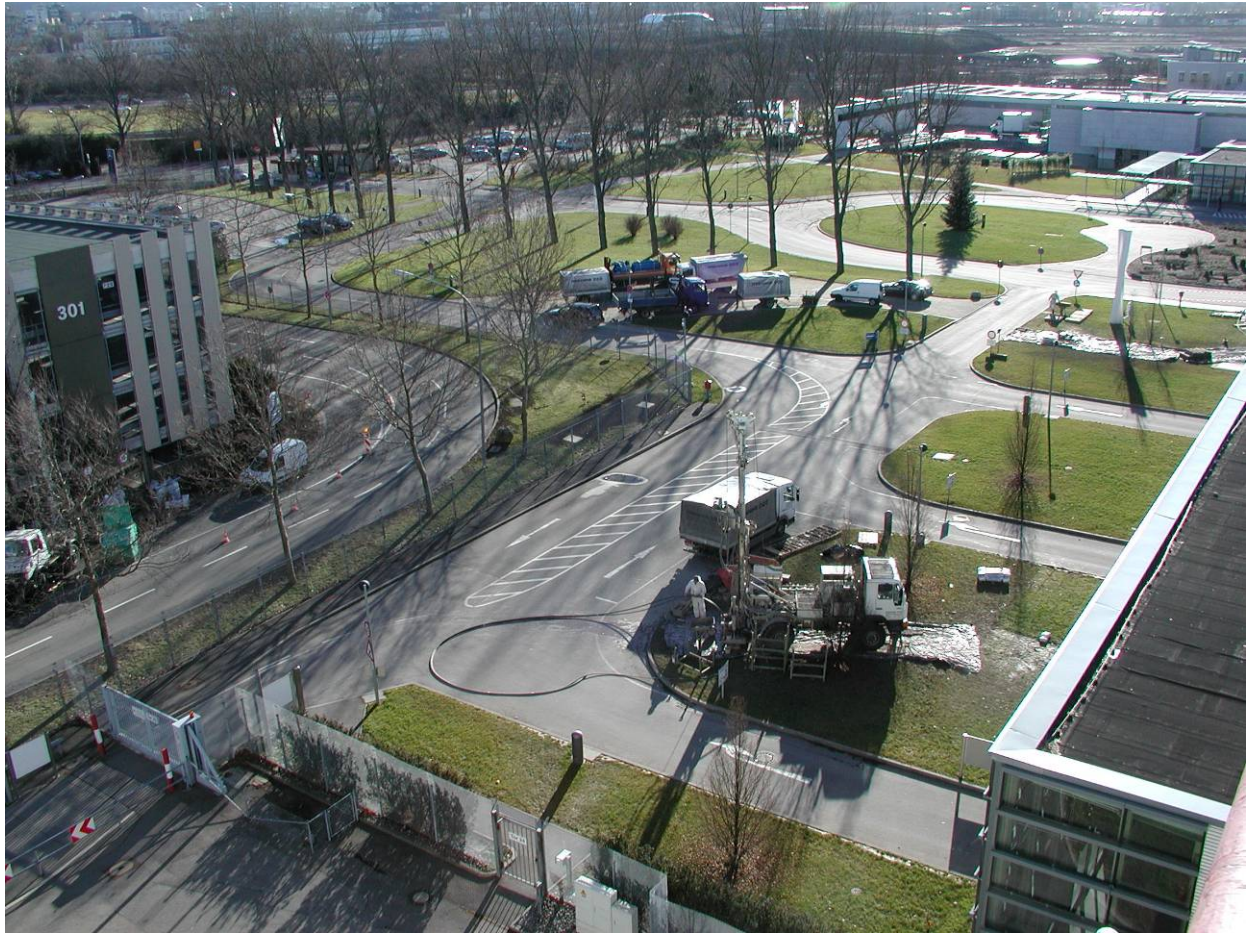
Abbildung 2: Erste großtechnisch durchgeführte ISCO-Sanierung in Deutschland an einem Standort der Automobilindustrie in Baden-Württemberg
