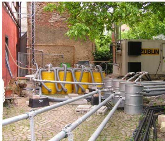
Grundwasser-Förderung, Bodenluftabsaugung, A-Kohleaufbereitung
