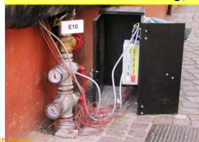
Grundwasser-Förderung, Bodenluftabsaugung, A-Kohleaufbereitung
