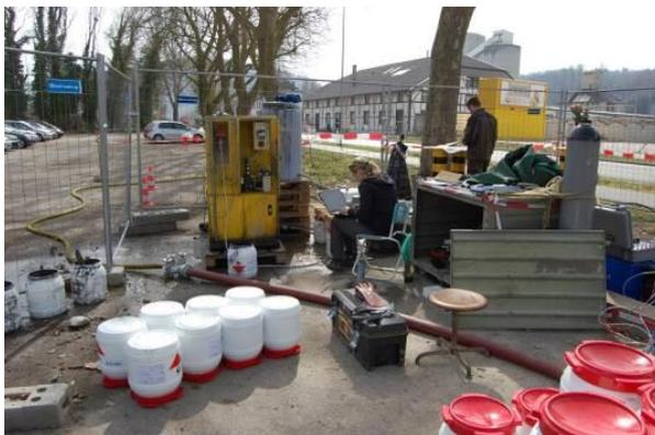
Abb.7: Injektion von FerMEG12 (nullwertiges nanoskaliges Eisen) in den Solvay-Standort © VEGAS, Universität Stuttgart, Deutschland
