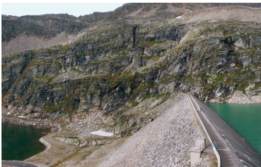
Bild 1: Ansicht des Hochwurtendamms
