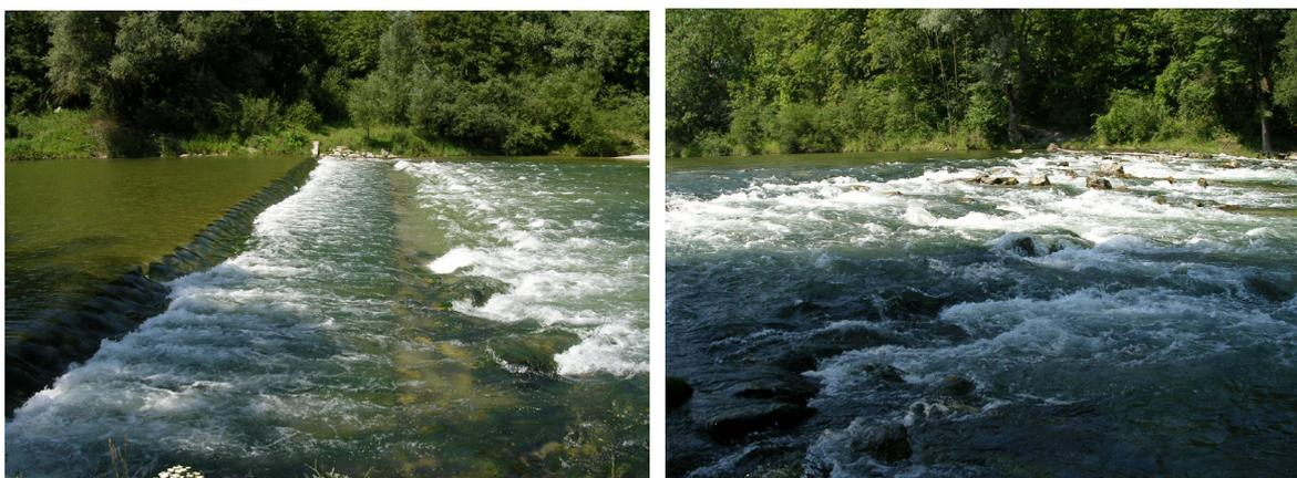
Abb. 20: Typische Sohlschwelle (links) und Sohlrampe (rechts)
