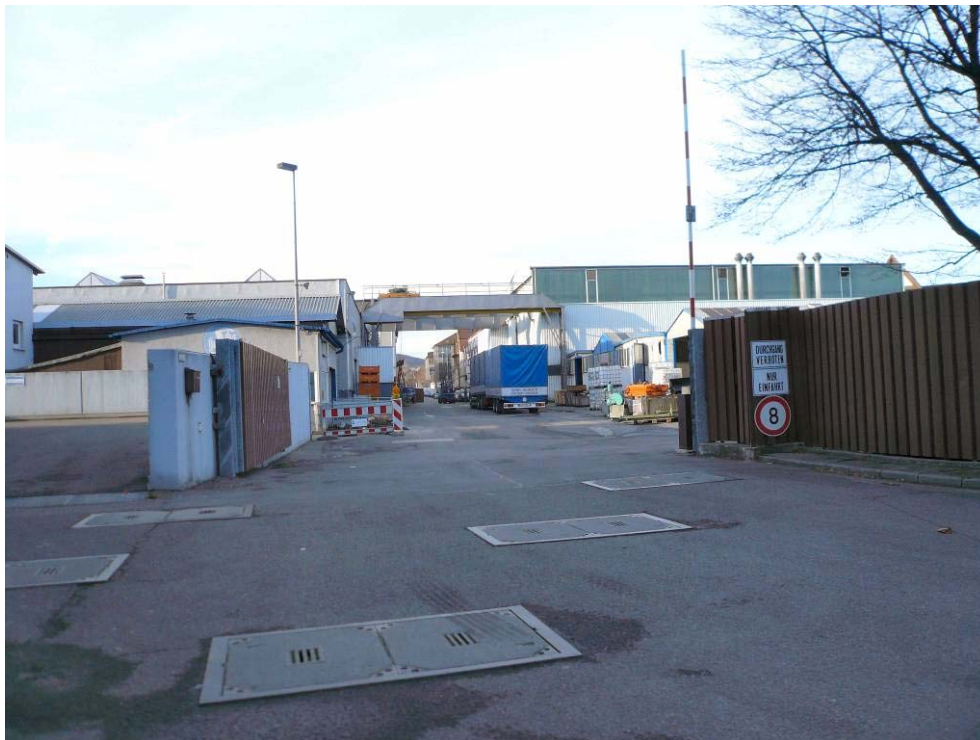
Abb. 2.2: Einfahrt zur ehemaligen Firma Gebr. Schoch Hartchrom GmbH
