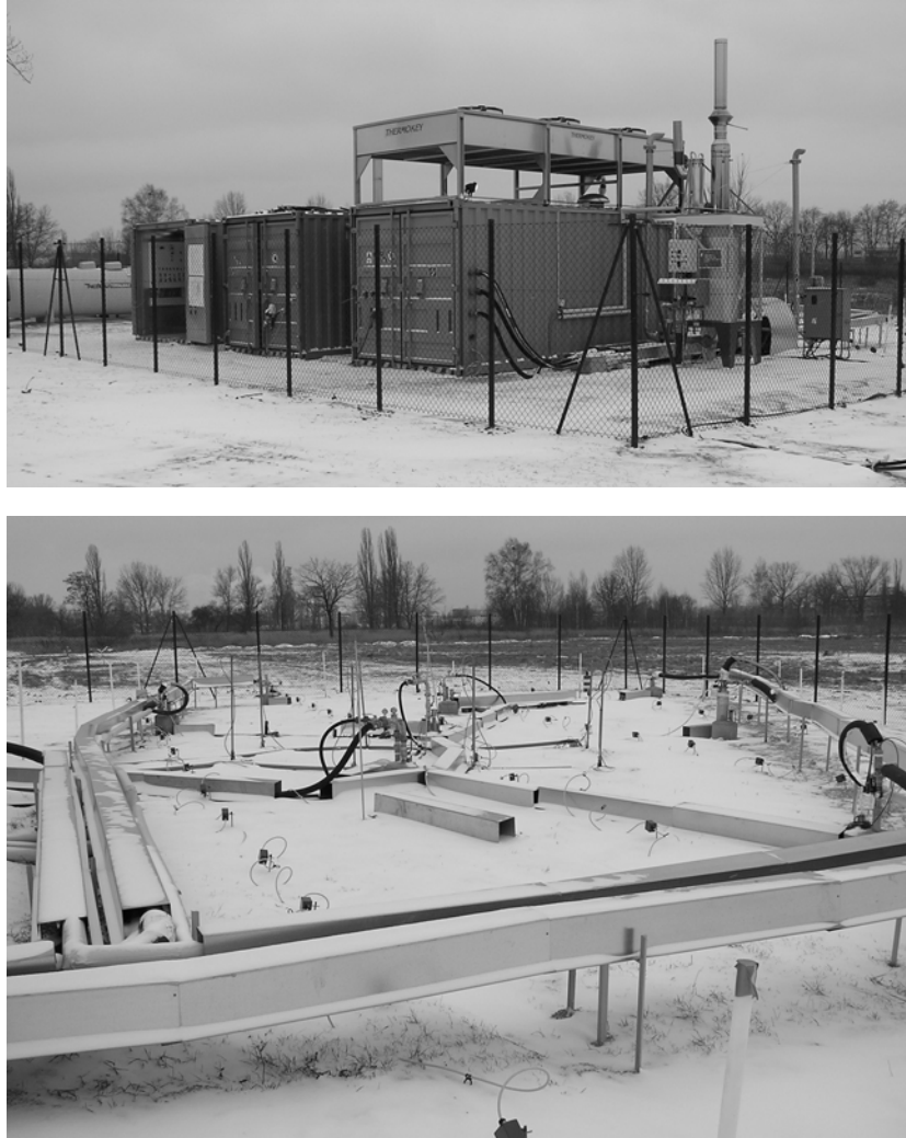
Abb. 6.4: MOSAM (oben) und Ausstattung Sanierungsfeld
