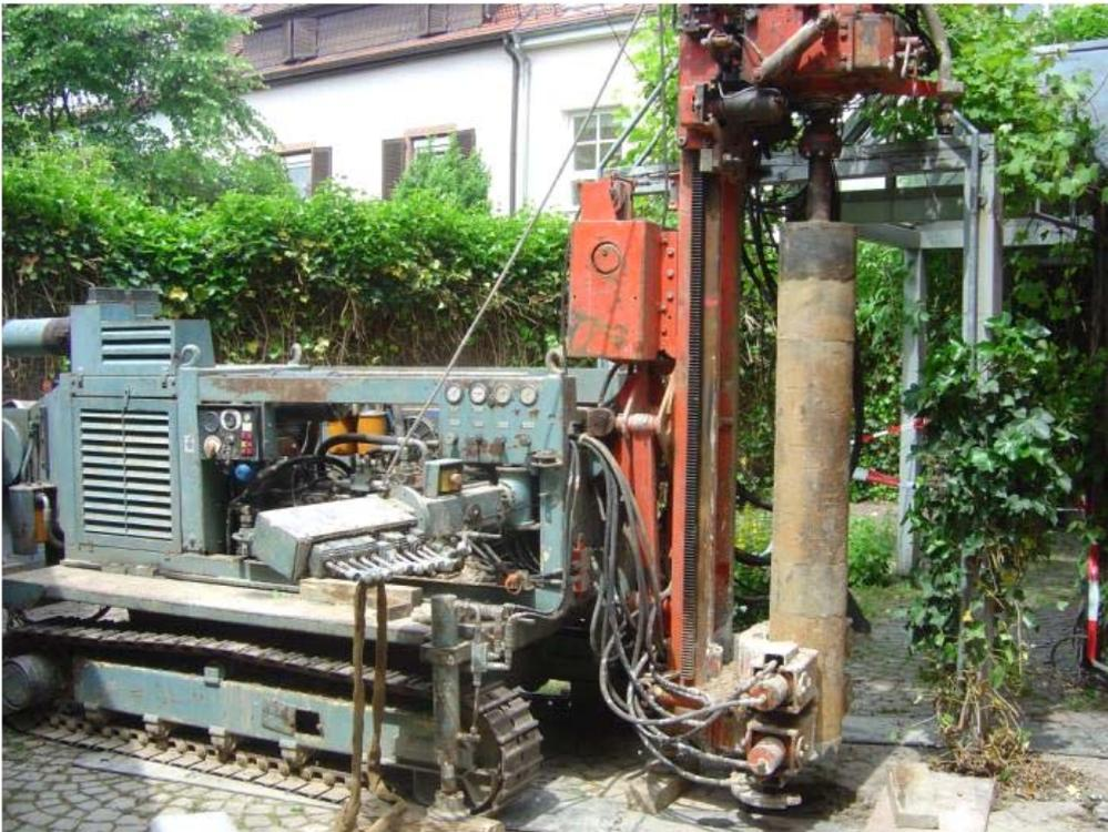
Abb. 7.2: Bohrarbeiten zur Installation des Injektionsbrunnens
