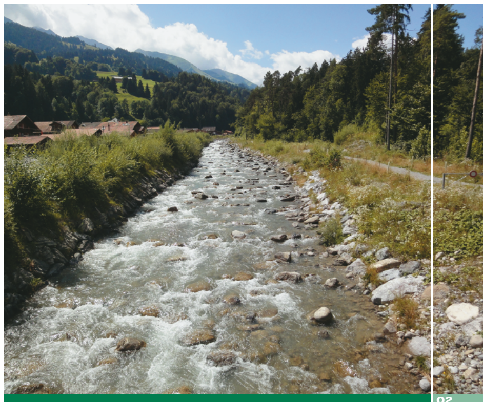
Eingeengtes, begradigtes Fließgewässer mit Uferverbau.
