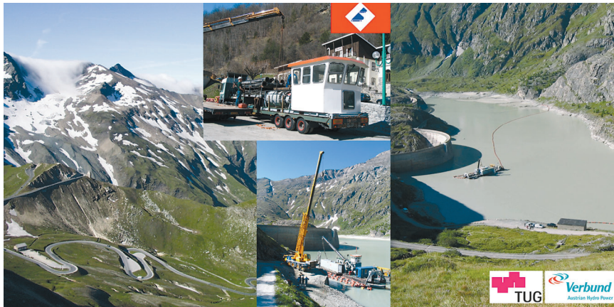
Bild 5: Transport des Saugbaggers auf Tiefladern über die Großglockner-Hochalpenstraße und Aufbau auf 2000 m ü. NN (links); Umlagerung von Feinsedimenten mit einem Saugbagger innerhalb des Speichers Margaritze (rechts)
