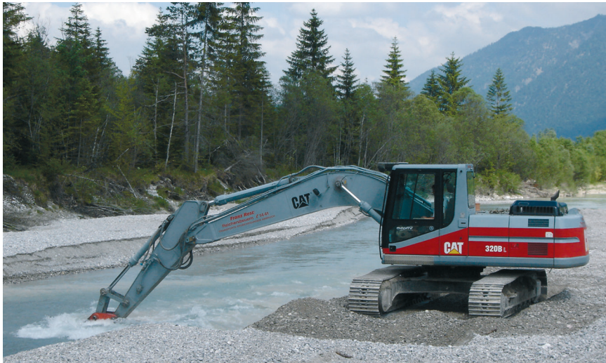
Bild 2: Mechanische Entnahme von Sedimenten mit konventionellem Baugerät
